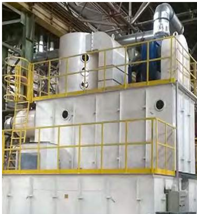
Рисунок 3 - Общий вид. АБХУ ООО «Техпромлит» РФ. АБХУ очистки вентиляционного воздуха от триэтиламина. Производительность по вентвоздуху 20 000 м 3 /ч
