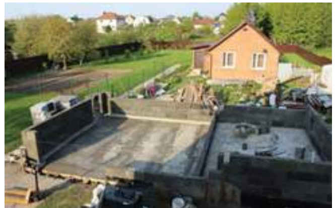
Рисунок 15. Строительство дома (Минская обл.)
