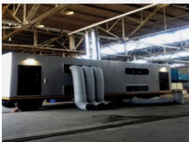
Теплогенератор на отработанных маслах в смеси с водой установленной мощностью 1 МВт на Минском авиаремонтном заводе
