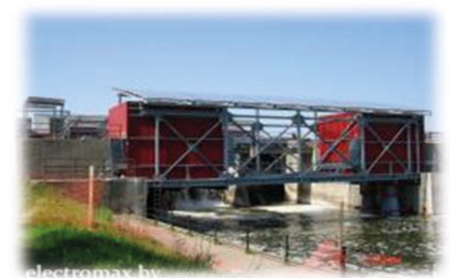
Дроздовская малая ГЭС установленной мощностью 320 кВт
