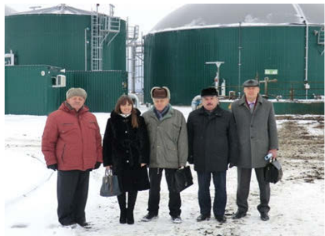
Биогазовый комплекс в агрогородке Лебедево Молодечненского района установленной мощностью 500 кВт
