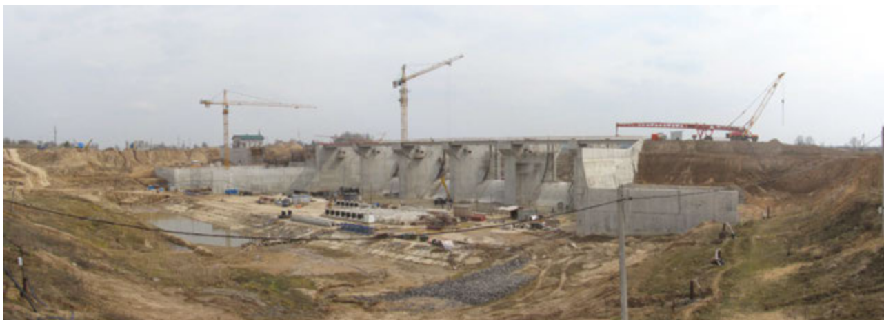
Строительство Полоцкой ГЭС 1
