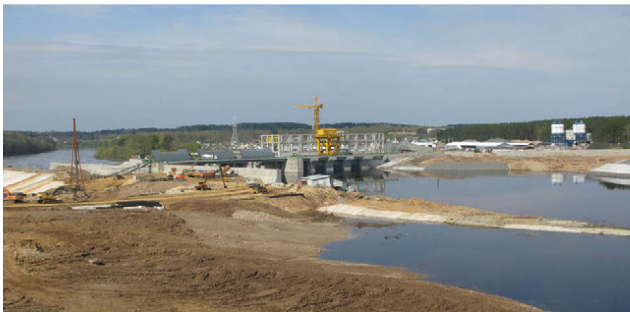
Гидроузел Витебской ГЭС. Левый берег верхний бьеф, со стороны судоходного шлюза
