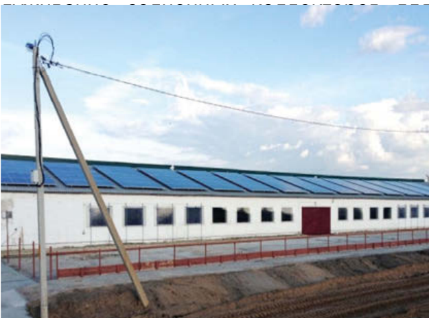
Солнечная электростанция в Логойском районе установленной мощностью 120 кВт
