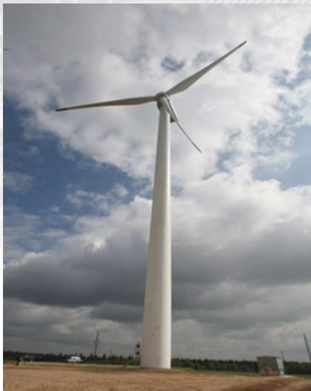
Ветрогенератор установленной мощностью 1,5 МВт в Новогрудке
