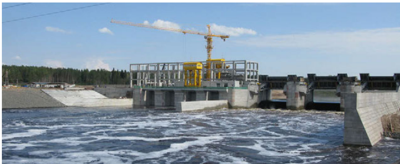
Гидроузел Витебской ГЭС. Левый берег верхний бьеф, со стороны судоходного шлюза
